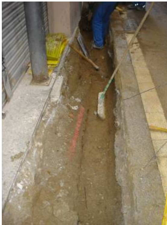
Foto 5: Vista de la rasa en la seva fondària màxima
